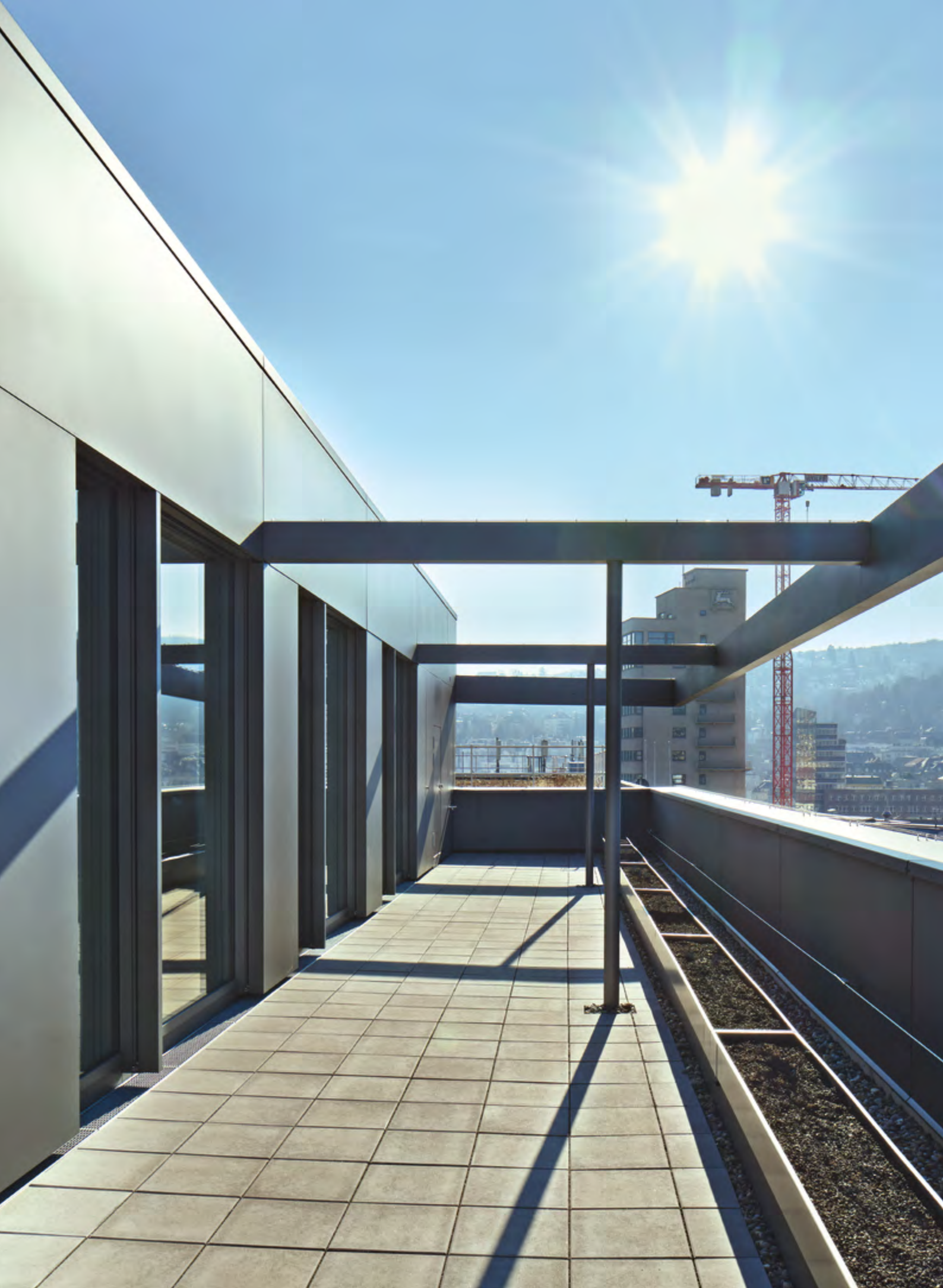
Büro- und Geschäftshaus, Königstraße 45, Stuttgart (Dachterrasse)
