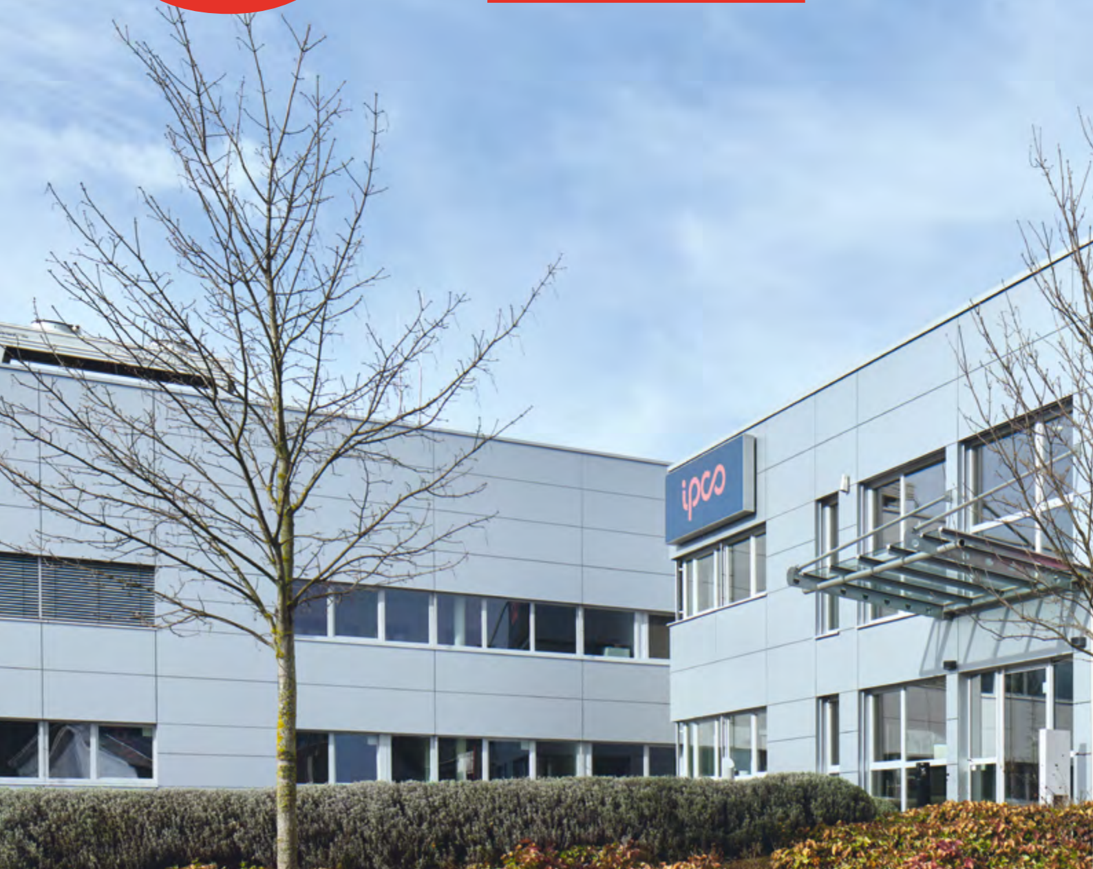
Produktions- und Bürogebäude, Göppingen
