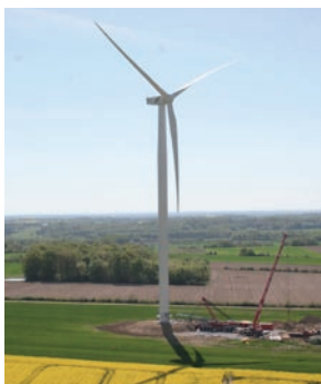
Errichtung Windpark Saint Pierre de Maillé I, Frankreich
