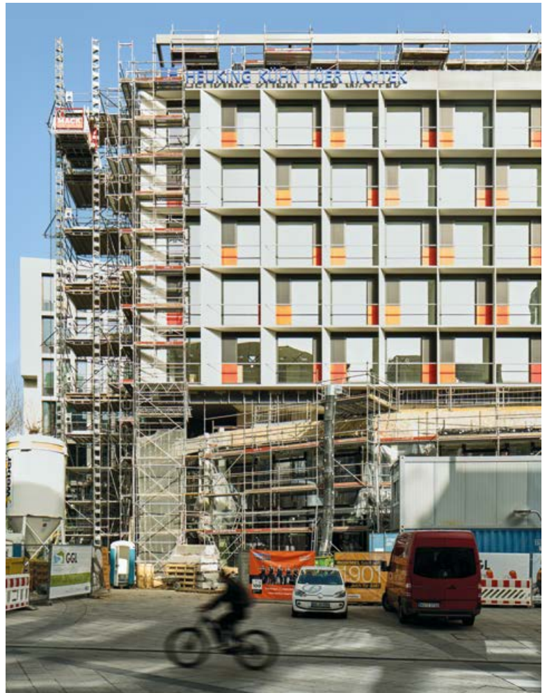
Königstraße 45, Stuttgart (Bautenstand Februar 2021)
