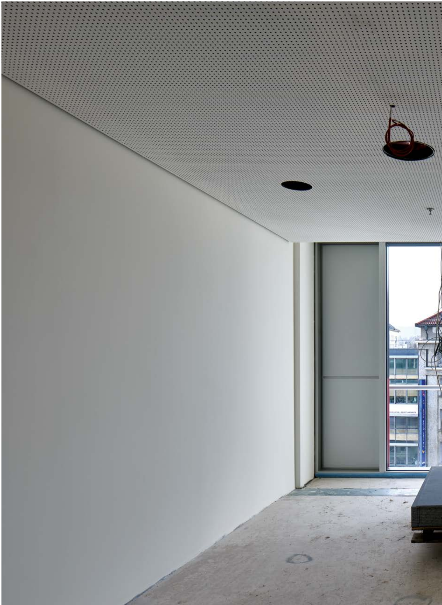
Büro- und Geschäftshaus, Königstraße 45, Stuttgart (Bürofläche 6. OG)
