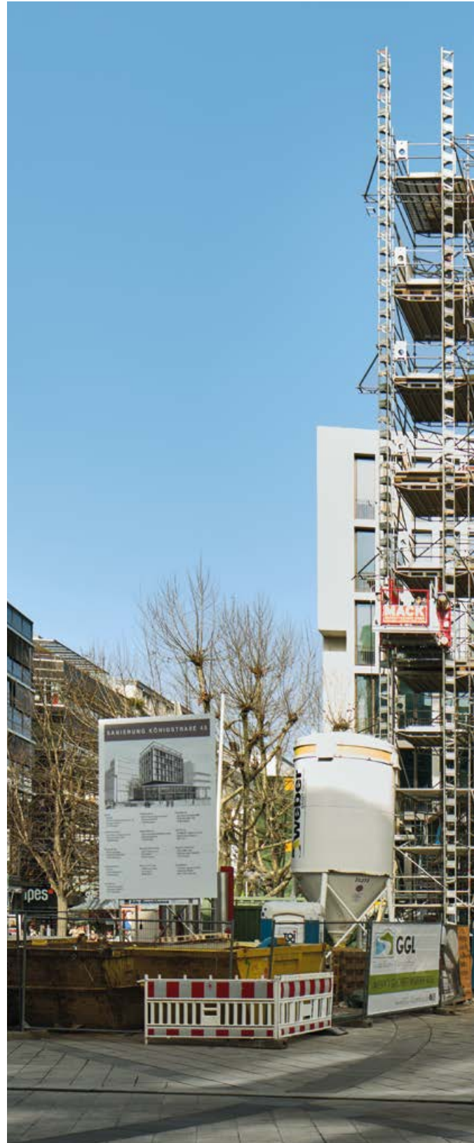
Büro- und Geschäftshaus, Königstraße 45, Stuttgart
