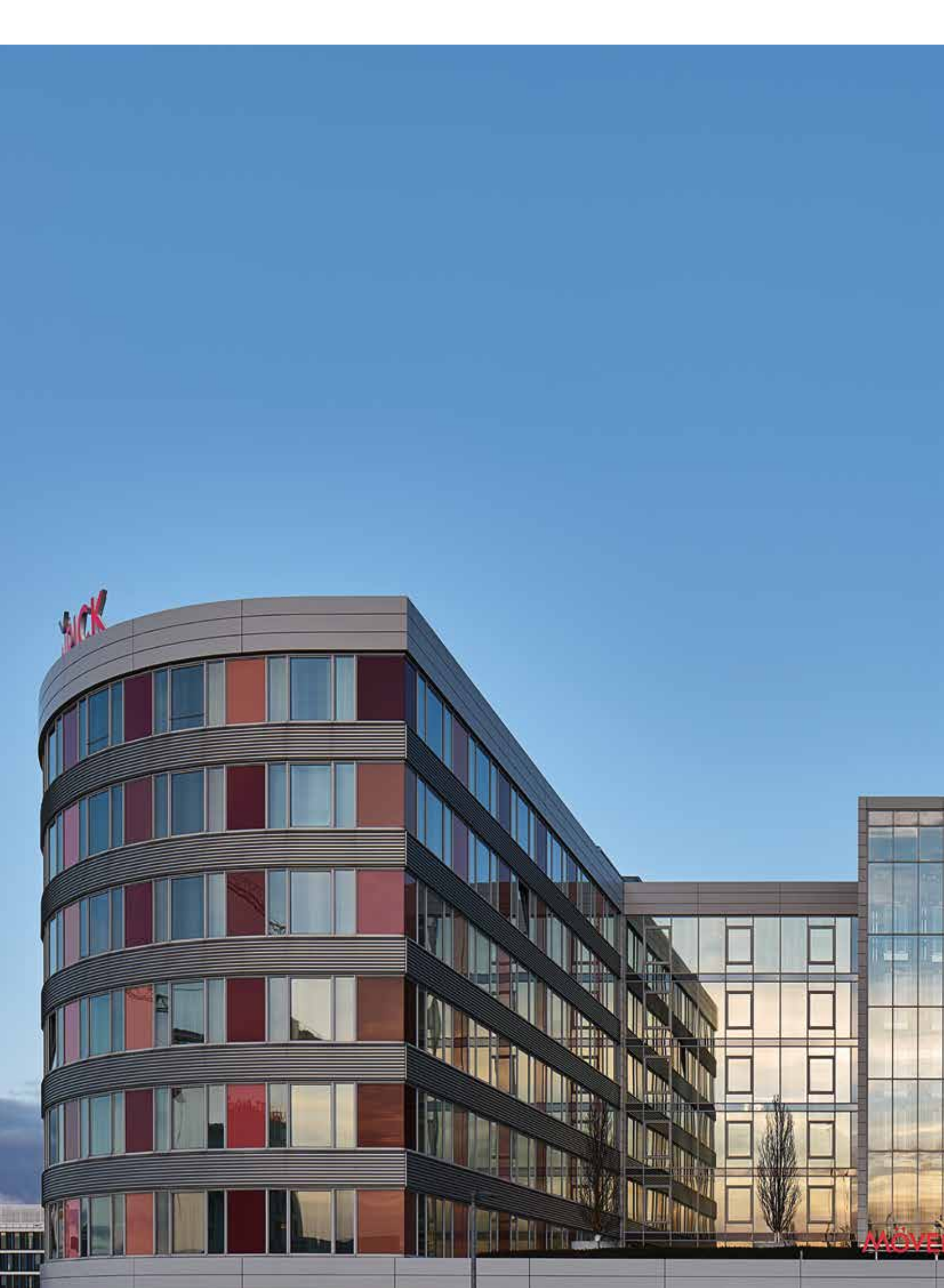
Airport Hotel, Flughafen Stuttgart
