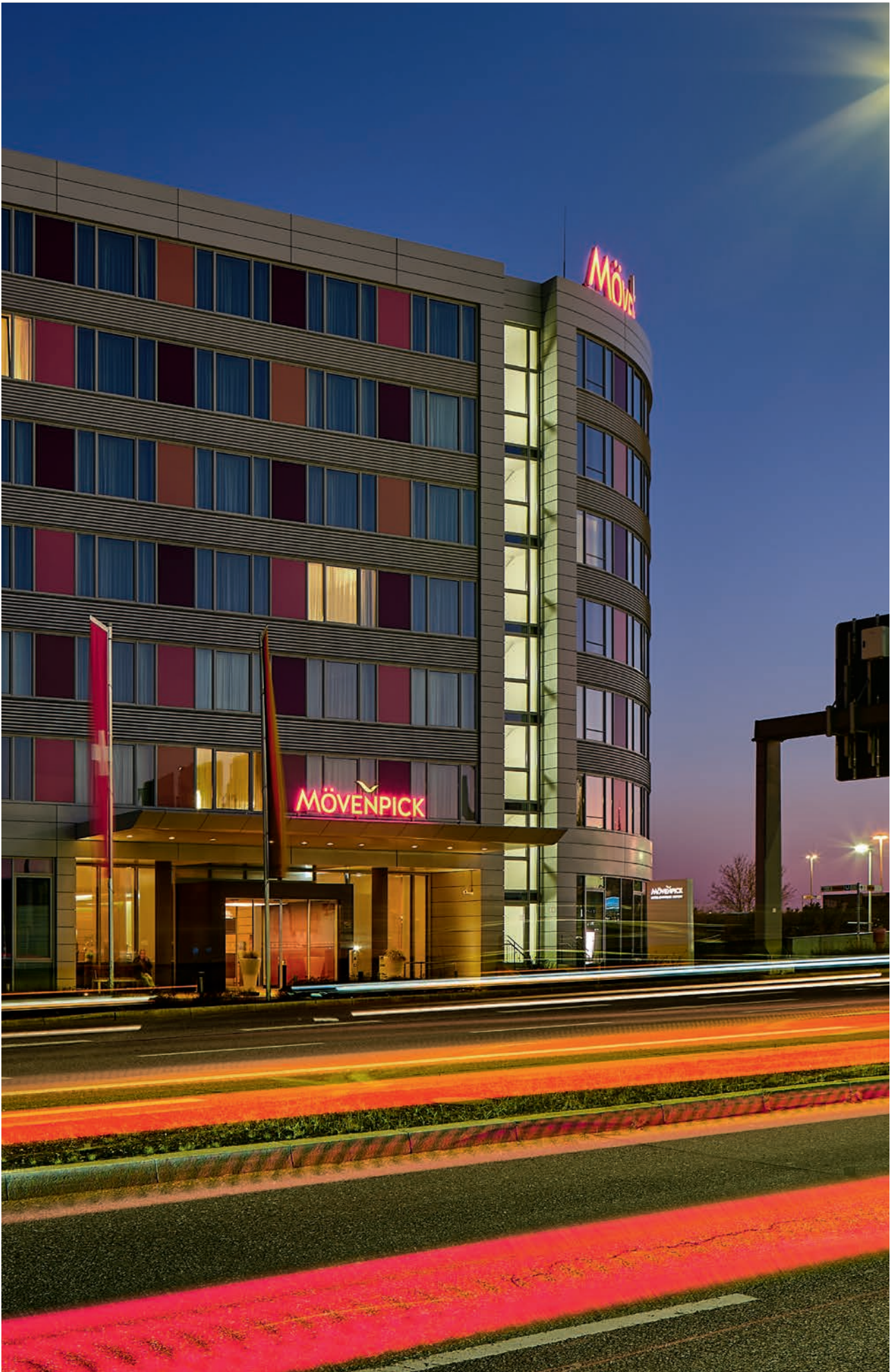
Aiporthotel, Flughafen Stuttgart
