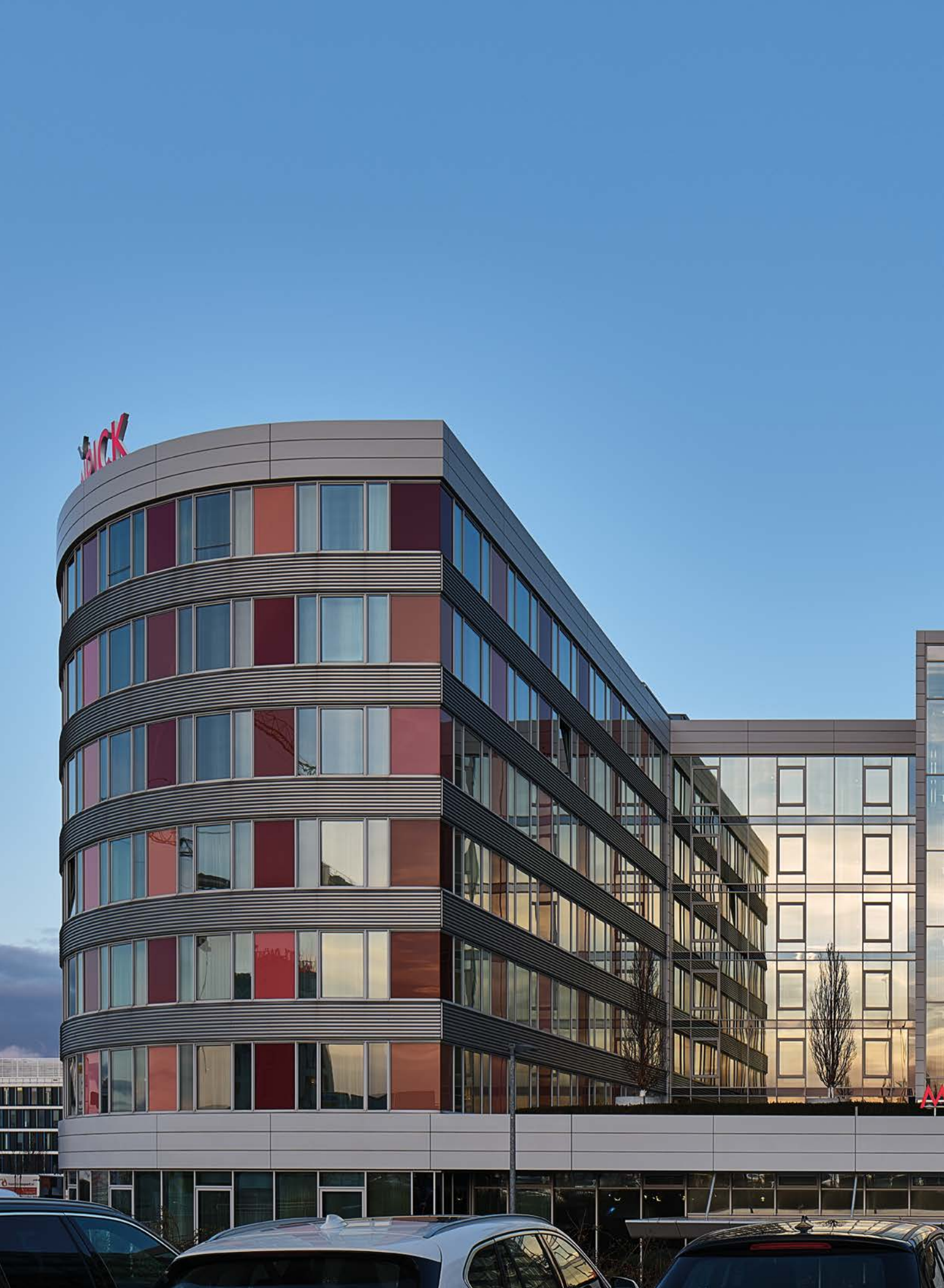
Airport Hotel, Flughafen Stuttgart
